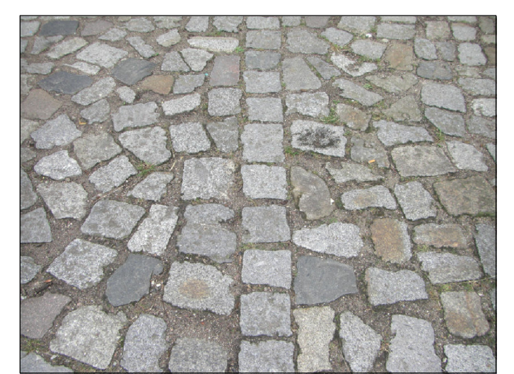
Polygonal - Natursteinpflaster in Stellplätzen mit Stellplatzmarkierung aus Granitrechteckpflaster
