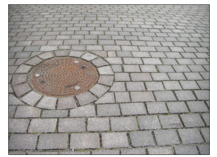
Gesägtes Granitrechteckpflaster, Oberfläche geflammt, Farbe: grau-rötlich Steinlänge und Steinbreite unterschiedlich Breite 12/14/16 Länge 18/26
