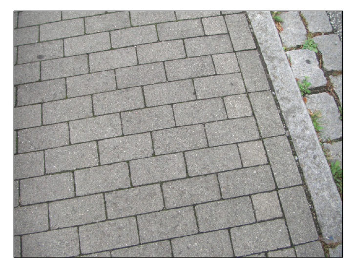
Betonsteinpflaster in Fahrbahnen und Gehwegen
