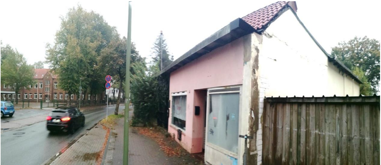
Kummerfelder Straße an der Grundschule (Hintergrund) mit älterem, kleinem Gebäude mit Spalten für Tagesquartiere von Fledermäusen
