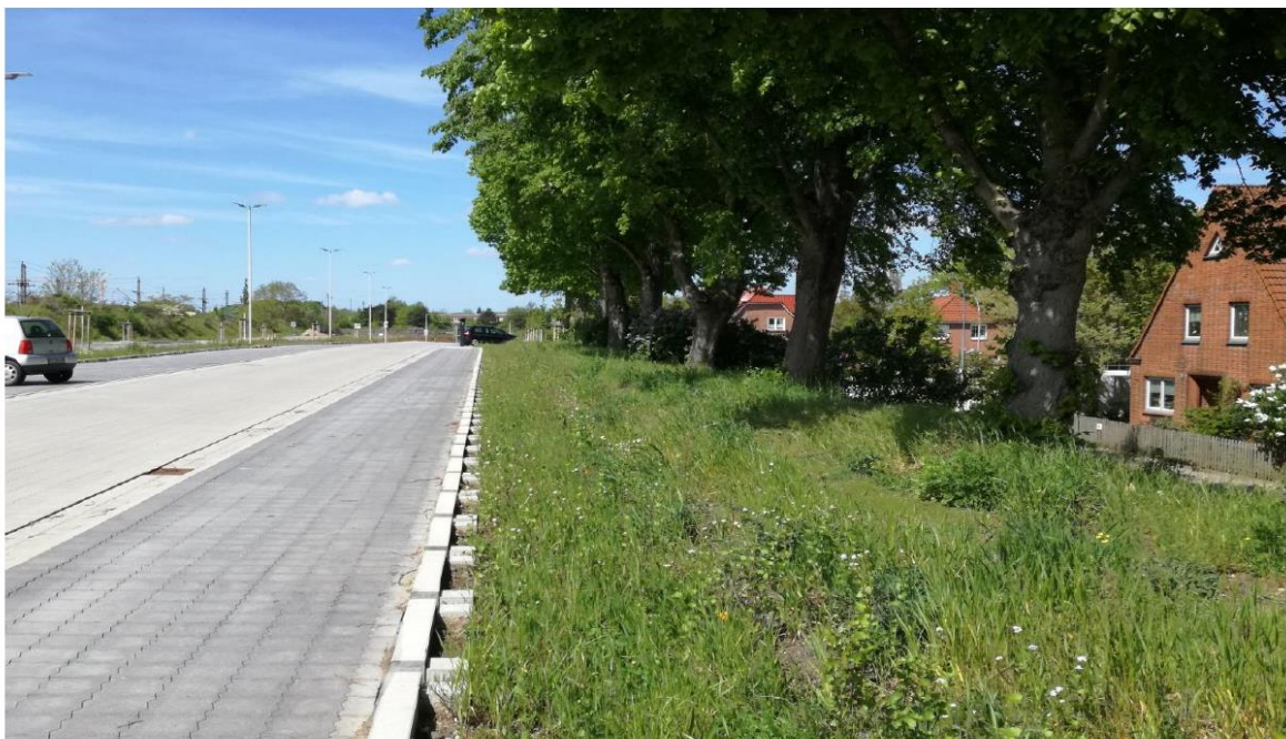
Sickermulde und Randstreifen an einer Baumreihe (Parkflächen der Mobilitätsdrehscheibe am Bahnhof Büchen)
