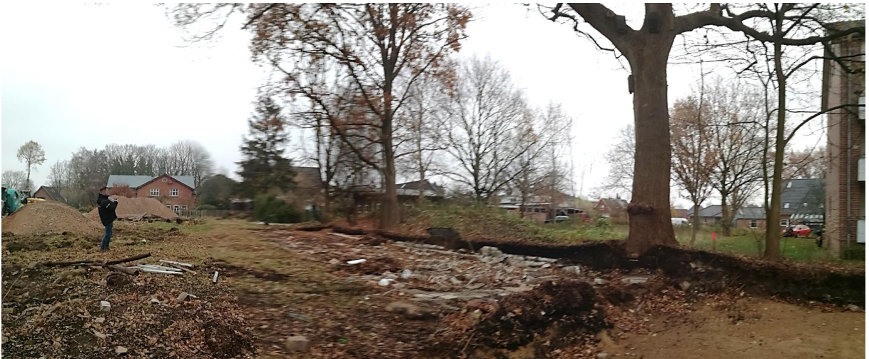
Nach Gebäude- und Schuppenabriss im Süden, geräumte Fläche mit Baumbestand an der Grundstücksgrenze
