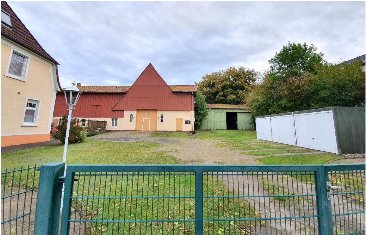
Wohnhaus und landwirtschaftliches Gebäude (vor Abriss) Grote Twiet, geringes Potenzial für Nischenbrüter eher in Nebengebäuden (Foto Specht)
