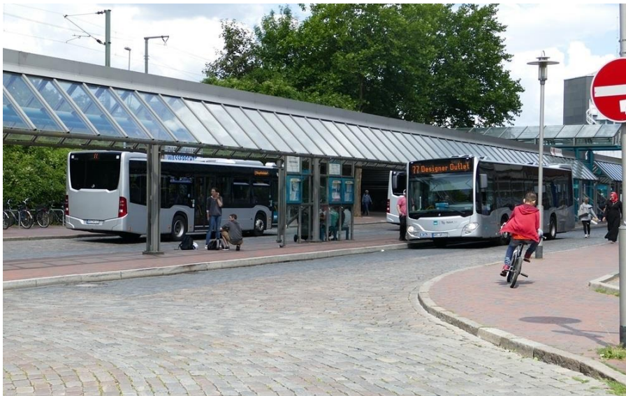
Abbildung 48: Bahnhofstraße mit Zentralem Omnibusbahnhof
