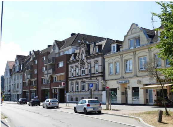
Abbildung 22: Bebauung Rendsburger Straße Westseite
