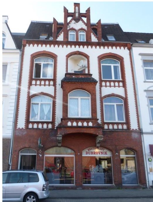
Abbildung 35: Beispiel für ein Gebäude mit mittlerem Modernisierungs- und Instandsetzungsbedarf
