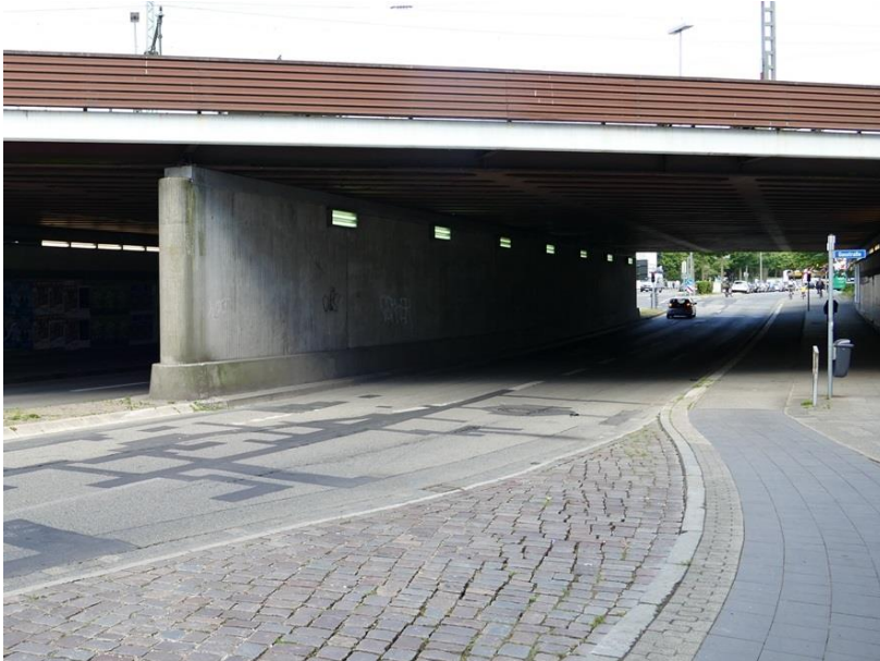
Abbildung 55: Kuhberg im Bereich Bahnunterführung
