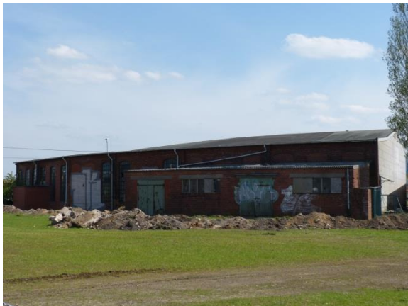
Abbildung 29: Ringlokschuppen (rückwärtige Ansicht)
