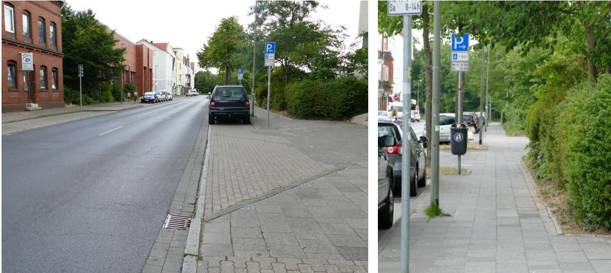
Abbildung 50: Friedrichstraße Blick Richtung Rendsburger Straße
