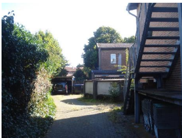
Abb. 4o Seitliche Zufahrt hinter der Lagerhalle zur Betriebsleiter Wohnung des Cafés
