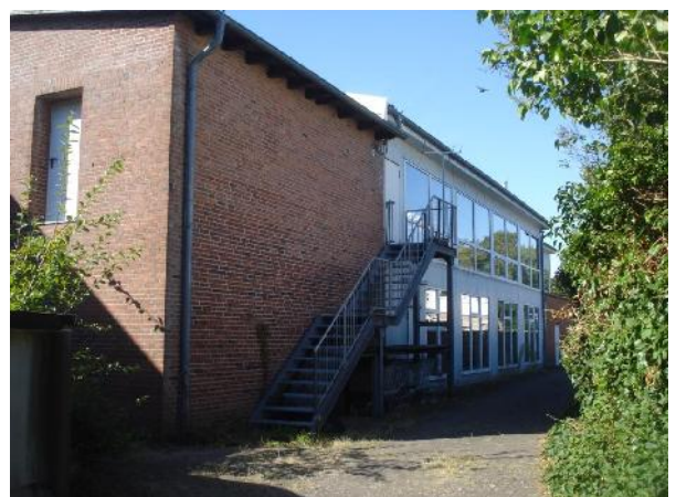
Abb. 4p seitliche Rückfront der Lagerhalle
