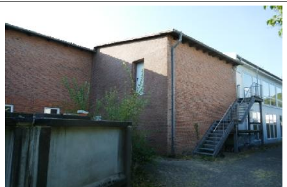
... der entsprechende Bereich der Gebäudeostseite.
