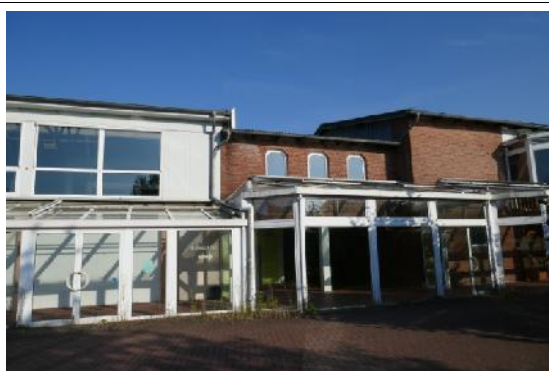
Gebäudewestseite: die neue weiße Halle (links im Bild) weist kein Potenzial für Fledermausquartiere auf, die roten Ziegelgebäude (rechts im Bild) schon.
