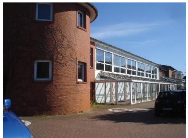
Abb. 4n Seitenansicht des Lagerhauses mit Glasvorbauten
