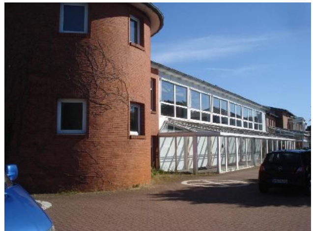
Seitenansicht des Lagerhauses vor Glasvorbauten
